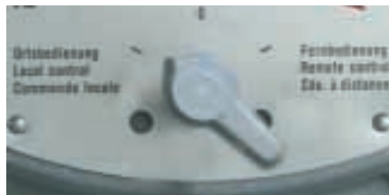
рис. М-3: Ключ-селектор на пульте местного управления
